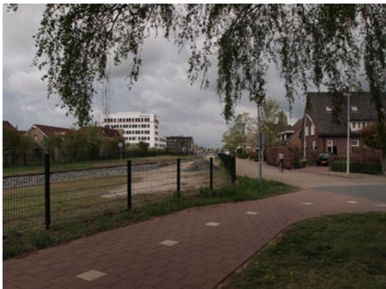
Afbeelding 7.: De onlangs (begin 2017) opgebroken aftakking van het voormalige GOLS-tracé naar Zelhem en Ruurlo, net buiten het station van Doetinchem.
